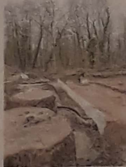
Boden-Vorarbeiten laufen auch schon im Bereich ehemalige Schlossterrassen.
