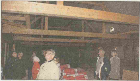
Baustellenrundgang 2: Besucher schauen sich in der künftigen Festhalle des Brau- und Brennhauses um.
